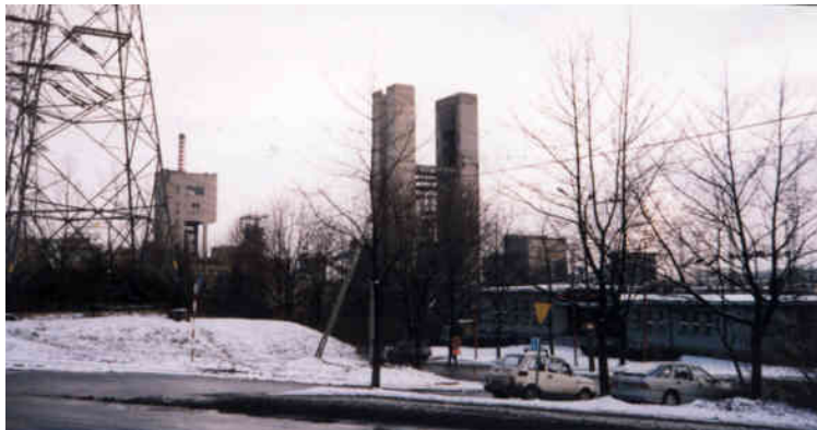
Kopalnia "Moszczenica - JasMos - niedokończony SKIP - fotos I/98 - EB
